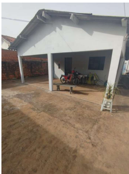
Foto 11 - Visualização area fundo do imóvel
