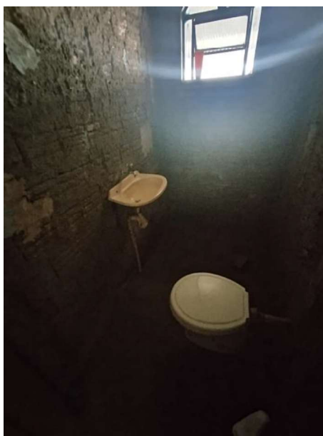
Foto 15 - Visualização do banheiro da edícula do imóvel
